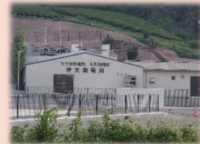
写真提供 大井川土地改良区 伊太発電所
