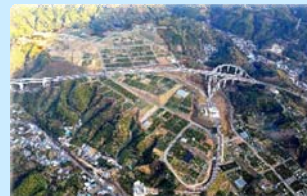
庵原地域の樹園地造成
