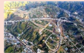
庵原地域の樹園地造成
