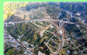
庵原地域の樹園地造成
