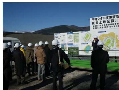
抜川調節池の工事現場の見学
